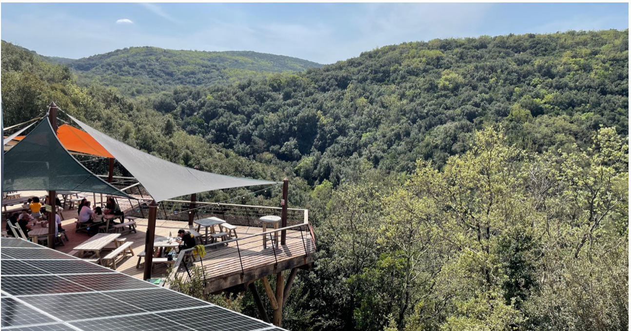
A gauche, la nouvelle ombrière photovoltaïque de la Grotte de la Salamandre - © Grotte de la Salamandre
